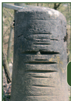
Trace de frottement du câble de halage ("Devant Fêchereux")
