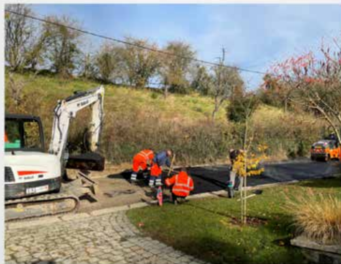
La réparation de la rue de la Fontaine par le service voirie. Les hommes reviendront fiers de leur travail ... et ils le peuvent !
